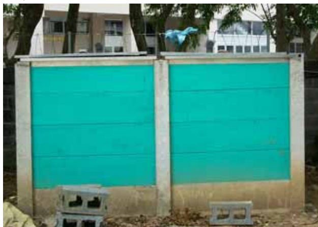
改良型通風式堆肥箱主體材料為水泥板、水泥柱及木板，使用年限可長達十年以上
