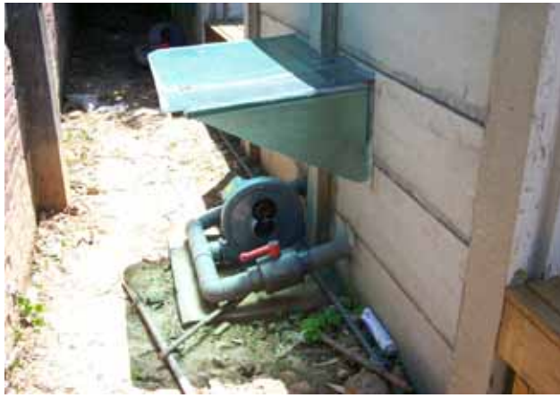
置放於堆肥箱背面之強迫式通風系統(鼓風機 1/2HP)
