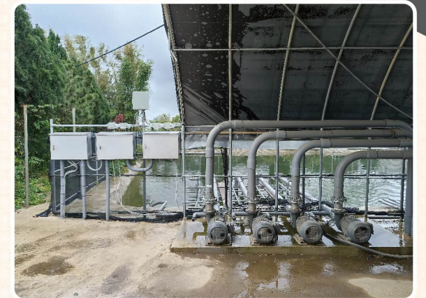
▲ 設施葉菜馬達控制器連動溫室電磁閥自動灌溉
