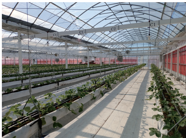
▲圖 4. 溫室內的鋼骨結構塗白漆，減緩熱能累積。
