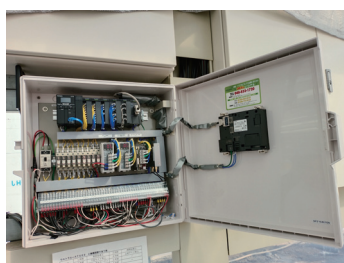
▲圖 6. 渡邊公司開發之溫室環境控制系統。
