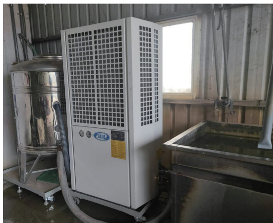
▲圖 3. 改良型冷水預冷系統，原冷藏庫蓄水池外接 16 千瓦冷水機加 600 公升冷水桶。
