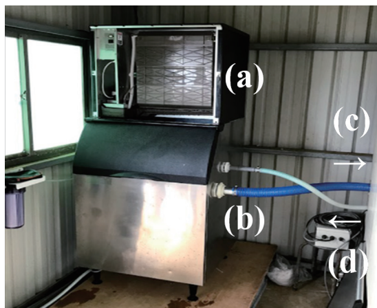
▲圖 4. 碎冰水冷機。(a) 製冰設備，(b) 貯冰槽，(c) 進蓄水池管，(d) 進蓄冰槽管。
