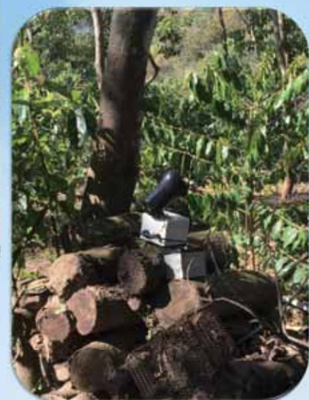
Lora無線網路安裝方式
