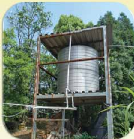
利用蓄水設備調節灌溉
