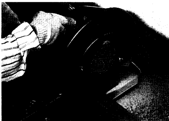
▲ 圖一：利用鋸子將塑膠管週邊鋸出2至3公分的長方形洞口以為通氣之用。
