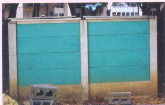
改良型通風式堆肥箱主體材料為水泥板、水泥柱及木板，使用年限可長達十年以上
