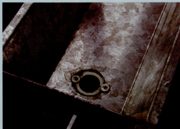
圖 2：套頭塑膠管插入圓孔中，做為導水管路
