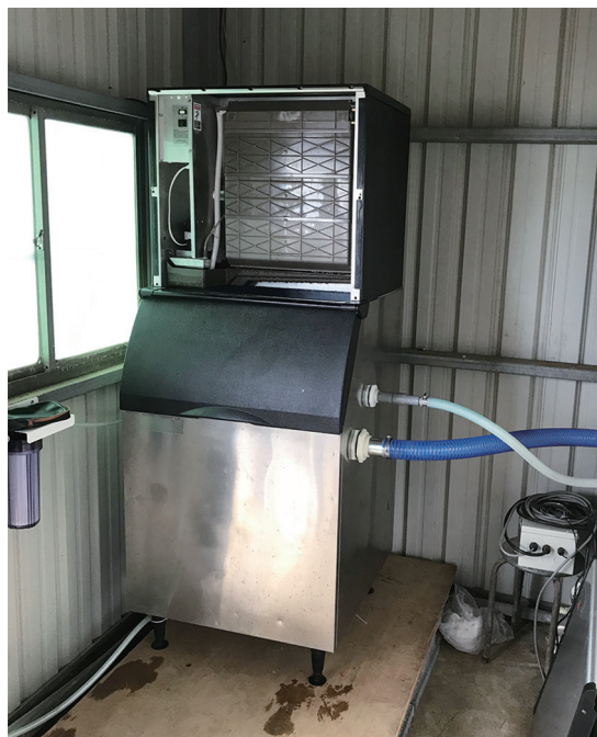
碎冰水冷系統，下方為貯水槽，上方為製冰設備，藍色水管導水進入冷藏庫蓄水池 (進水口)，白色水管導水出冷藏庫回貯水槽 (出水口)
