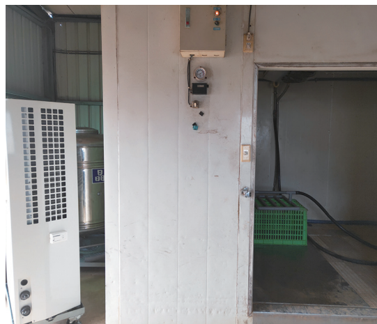
舊型氣冷冰水冷藏庫改機完成後大幅提升預冷效率
