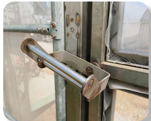
高緻密度防蟲門具有的開關門機構（手把），關門後能進一步迫緊內外框體
