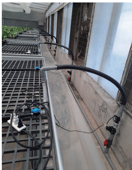
▲ 圖 3. 栽培床設置流量計、電磁閥及控制器等設備。
