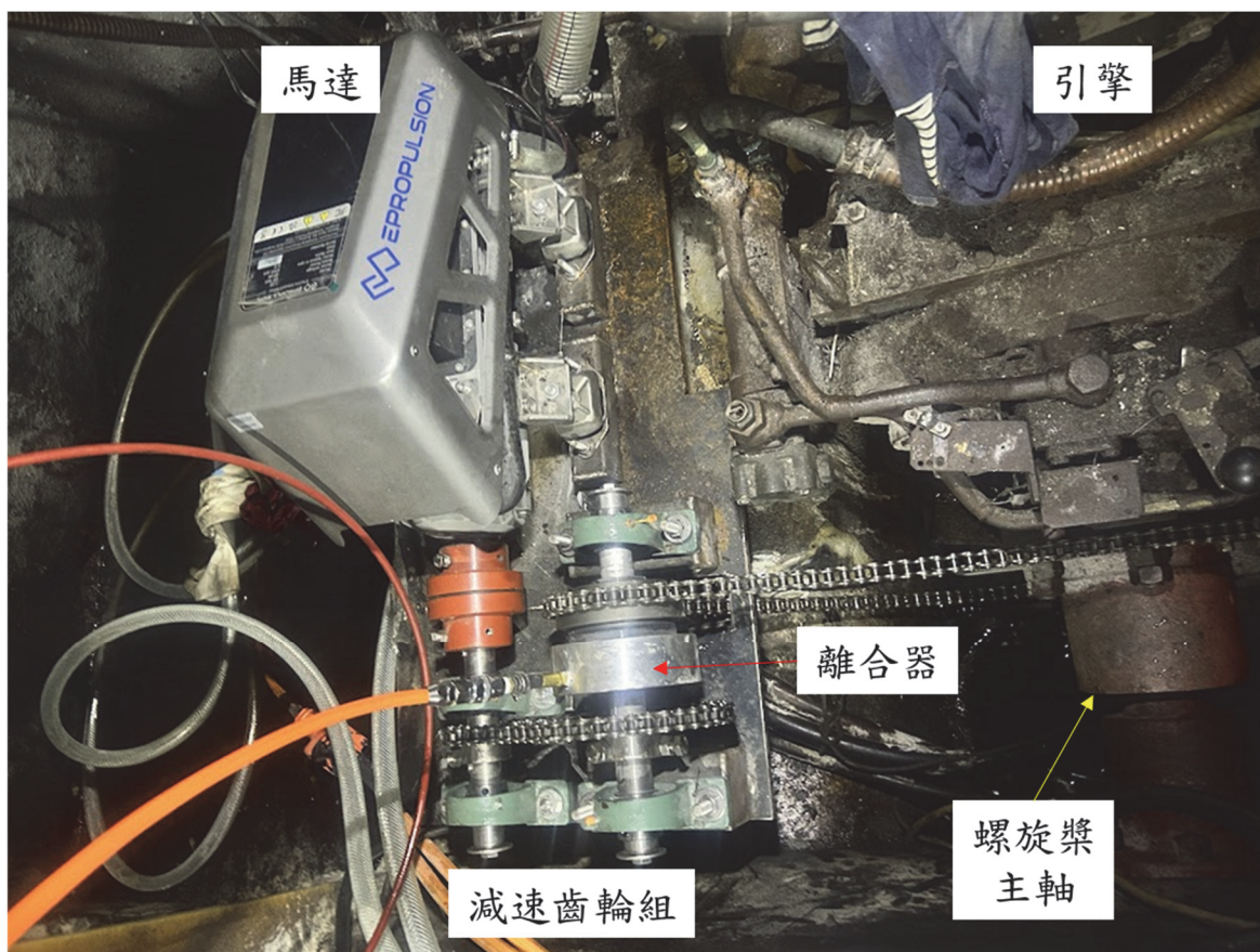
圖 4、完成安裝的油電系統馬達與傳動系統組
