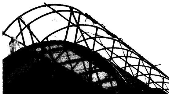
▲圖七、連棟設施上之太子閣若能在施工時加強其主體結構間的焊接工作，在颱風過後其結構未見損害，但塑膠布部分仍遭受颱風的破壞。
