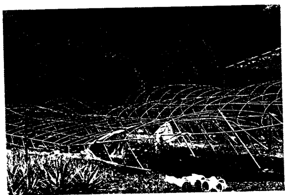
▲圖八、四分管結構的塑膠布簡易設施最易受到颱風的破壞，往往整棟變形傾倒，損失慘重。
