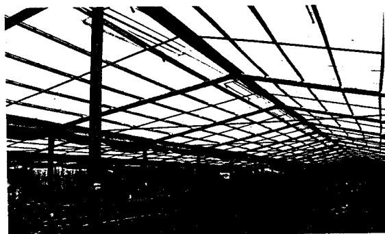
▲圖三、簡易連棟設施，以四寸鍍鋅鐵管支撐整個鋼樑，上蓋PC浪板，在此調查中受損情形輕微。
