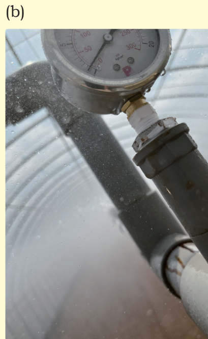
▲(a) 幫浦後方及(b)溫室前方(銅質固定式噴頭可直接更換為壓力計)安裝壓力計。
