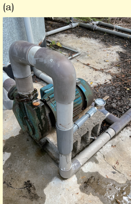
▲(a) 幫浦後方及(b)溫室前方(銅質固定式噴頭可直接更換為壓力計)安裝壓力計。
